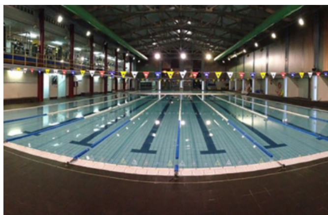
Figura 5.2: Piscines interiors Centre Esportiu Municipal Sistrells
