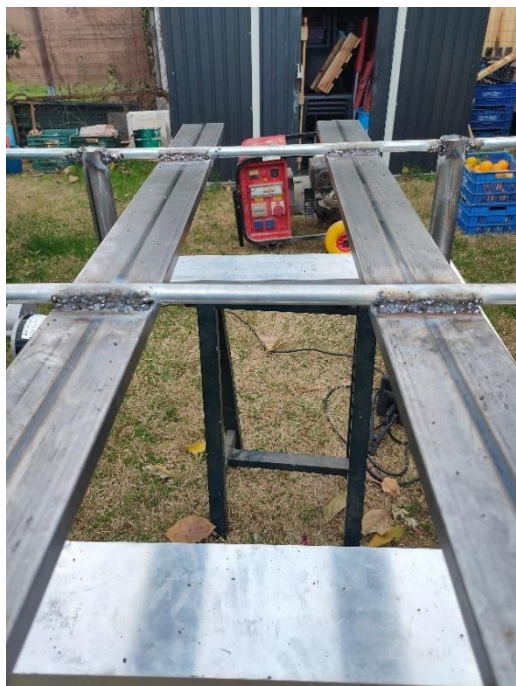
Ilustración 47.- Perfiles que atraviesan la estructura. [Fuente Propia]
