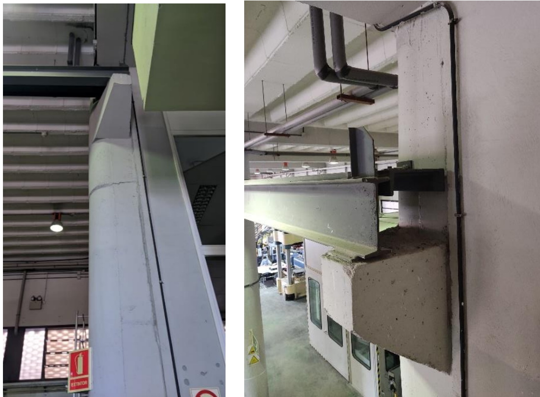
Figura 4. Pilar 13B y su ménsula correspondiente.
