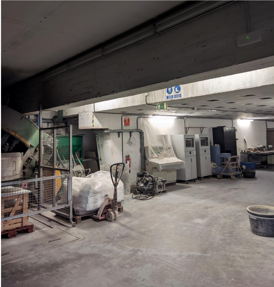
Figura 14. Sótano. Viga existente en el eje 18.
