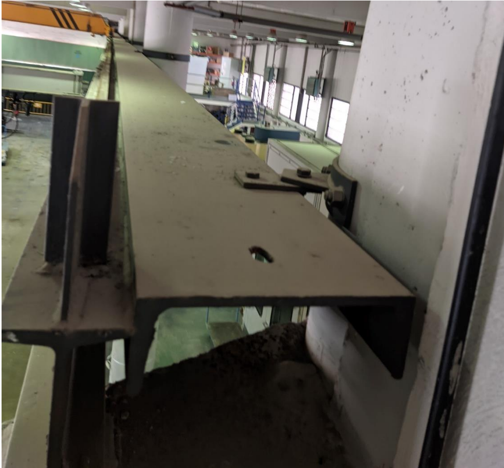
Figura 11. Viga carrilera.
