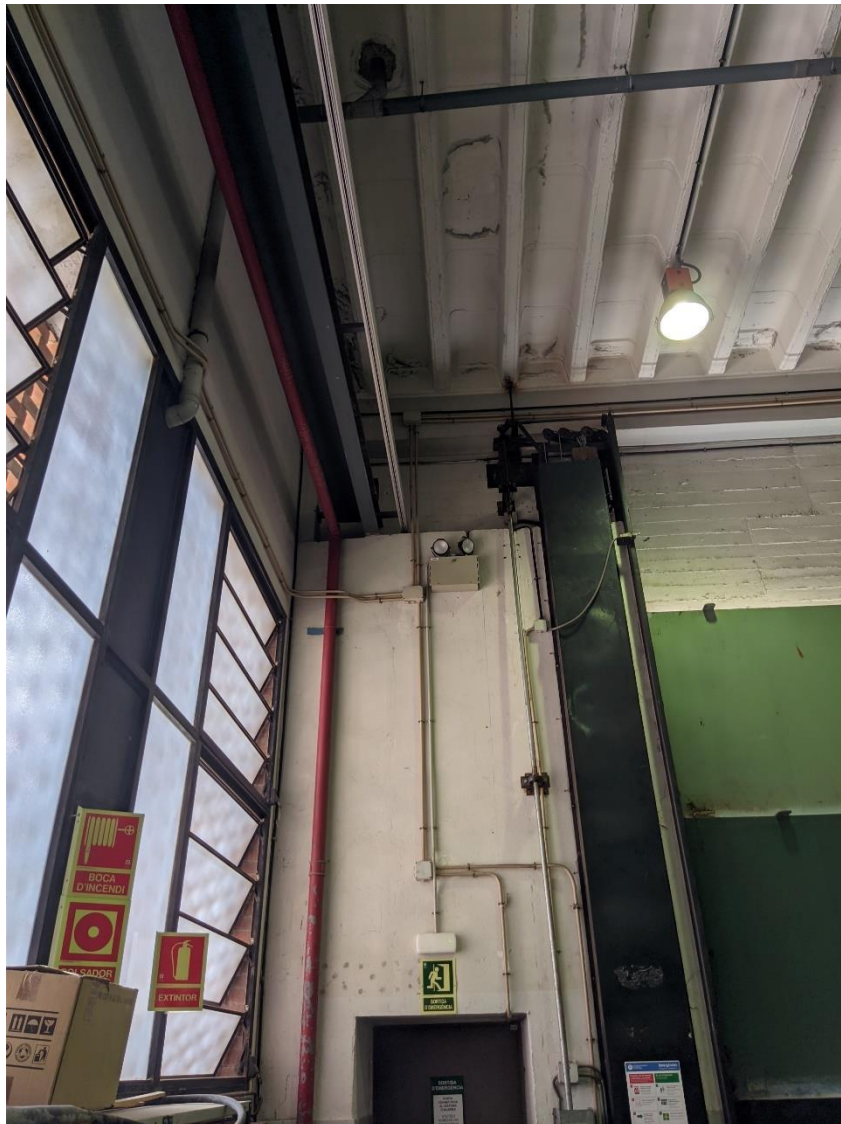
Figura 10. Apoyo de la viga carrilera en la intersección de los ejes 19 y A.
