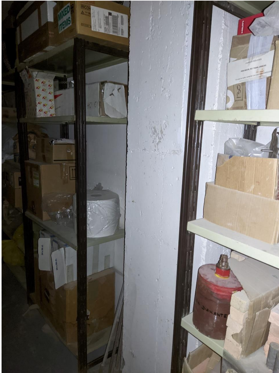
Figura 13. Pilar del sótano.
