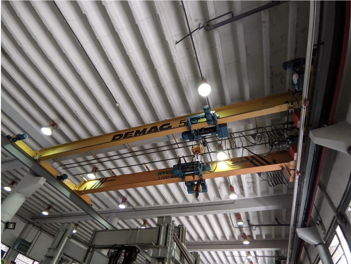
Figura 8. Losa nervada y puentes grúa.
