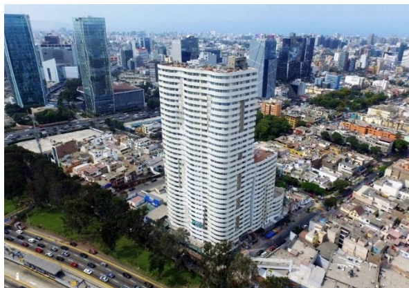
Figura 2.6: Vista aérea de edificio Lux. (FaseDOs Ingeniería & Construcción, 2018)
