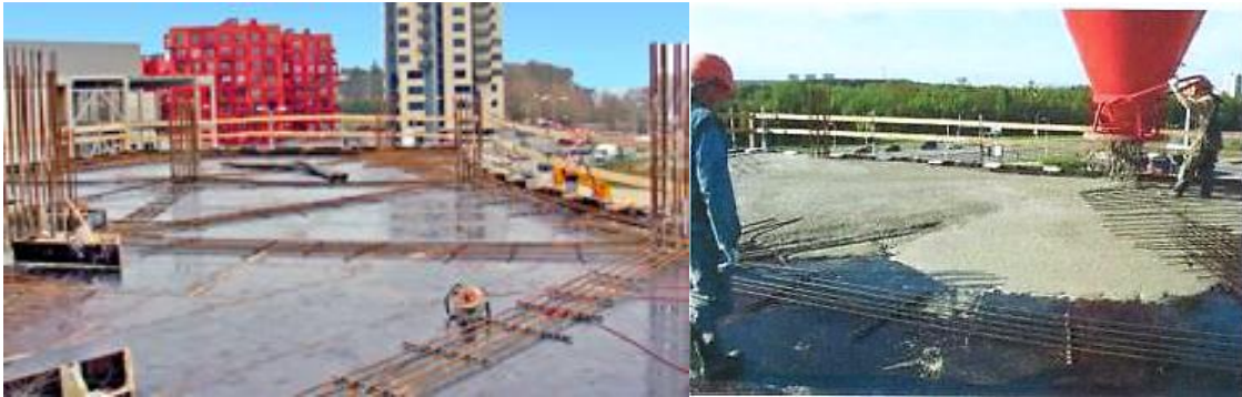
Figura 2.15: Edificio Rocca Tower, Ejecución de la armadura APC (izquierda) y puesta en obra del HRFA (Derecha) (ArcelorMittal, 2021)
