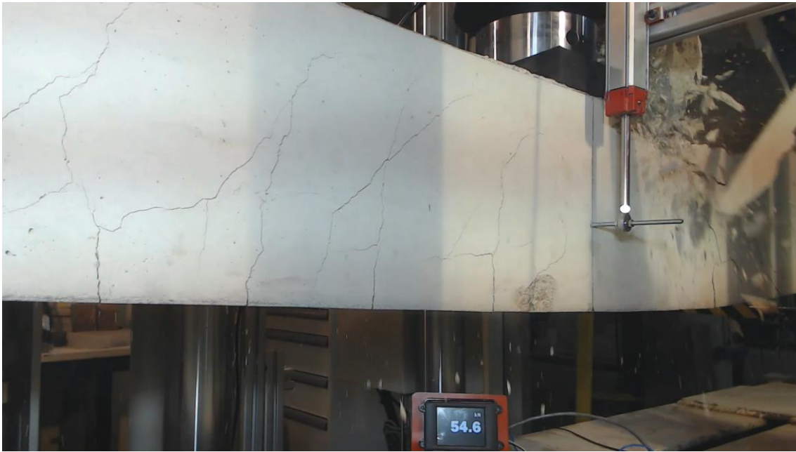
Figura 63. Fisuras Viga 2V13 a 54,6 kN, Grupo 1.
