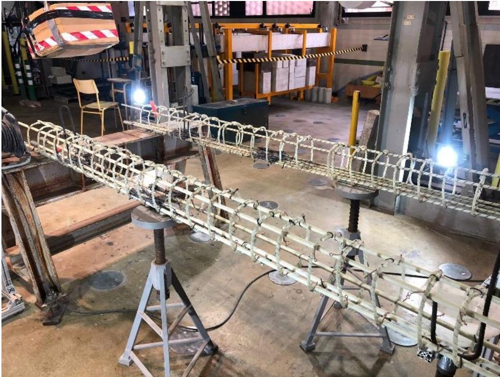
Figura 21. Armadura montada de las vigas de armadura pasiva.
