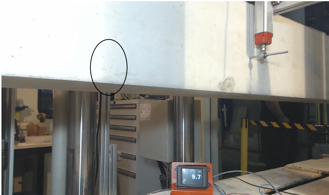
Figura 59. Fisuras Viga 2V10 a 9,7 kN, Grupo 1.
