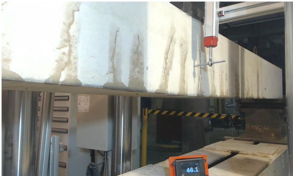
Figura 56. Fisuras Viga 4A10 a 46,1 kN. Grupo 1.
