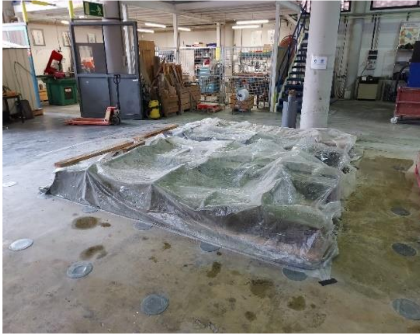
Figura 25. Curado de las vigas con armadura pasiva.
