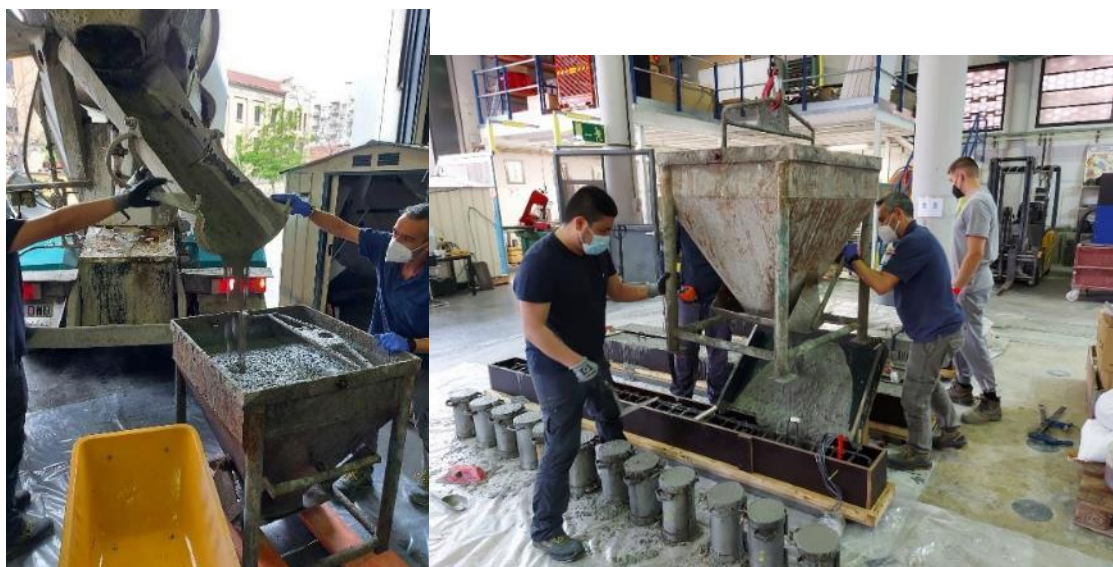
Figura 24. Vertido del hormigón en las vigas con armadura pasiva.
