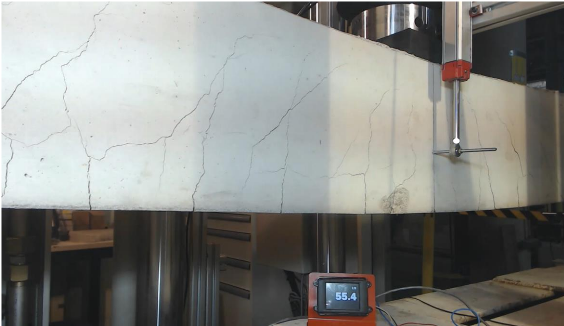
Figura 61. Fisuras Viga 2V13 a 55,4 kN, Grupo 1.
