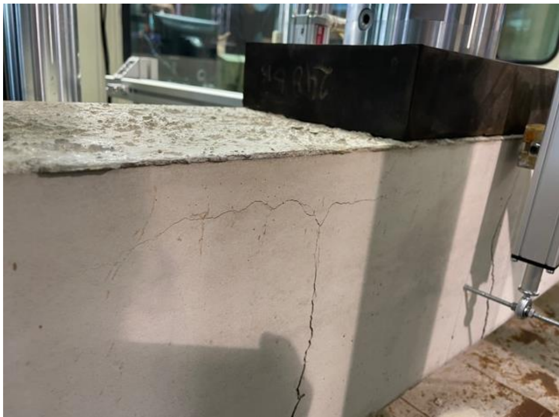
Figura 65. Fisuras Viga 2T13b a carga de rotura, Grupo 1.
