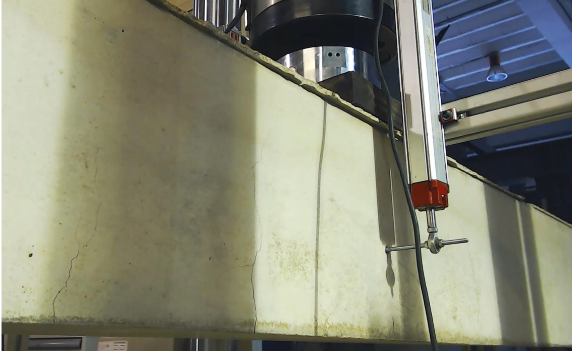
Figura 66. Fisuras Viga 5V10. Grupo 2.
