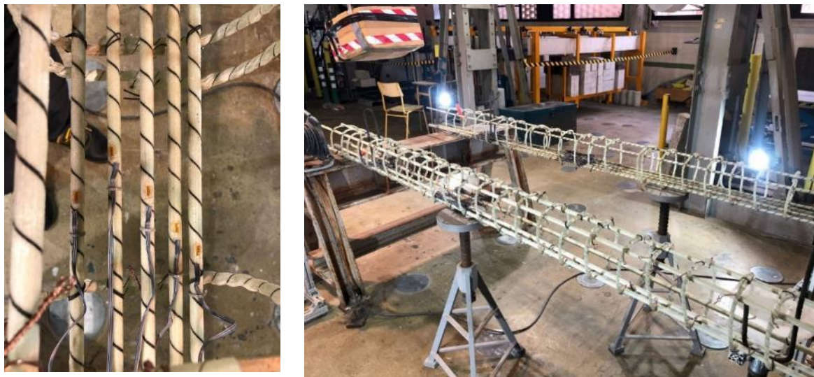
Figura 40. Situación de las Galgas en la armadura.
