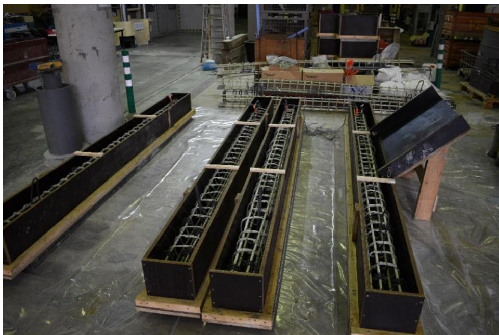
Figura 22. Armadura dentro del encofrado, vigas de armadura pasiva.
