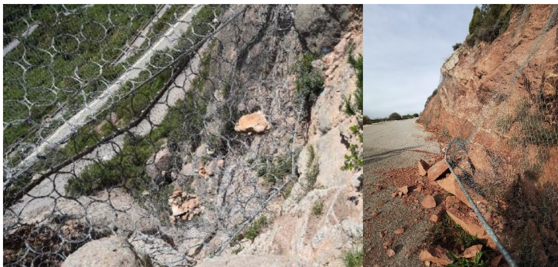
Figura 44. Bloques retenidos en las mallas de Coves del Salnitre (ICGC, Notas técnicas de visita pel seguiment geològic de la muntanya de Montserrat, 2014- 2020)
