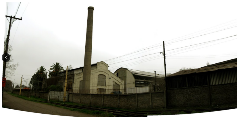
Fig. 10. Acceso al complejo de la Maestranza San Eugenio. Fuente: elaboración propia.
