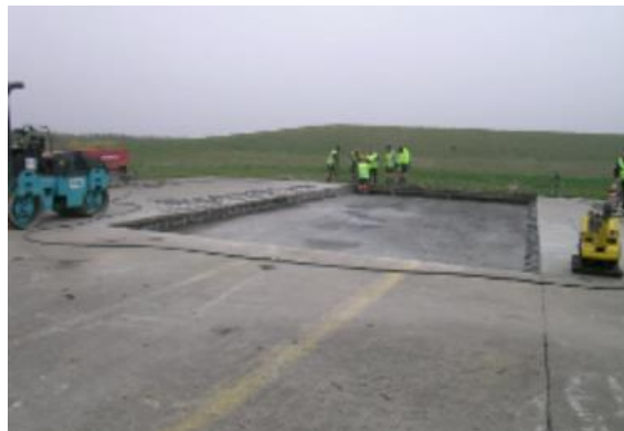
Figura 29. Aplicación de CSA07. Reparación de emergencia de pavimentos de hormigón. Fuente: F&H Cement.
