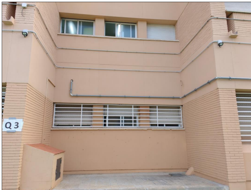
Figura 7. Ubicación del piloto, ala sur del Institut Les Salines
