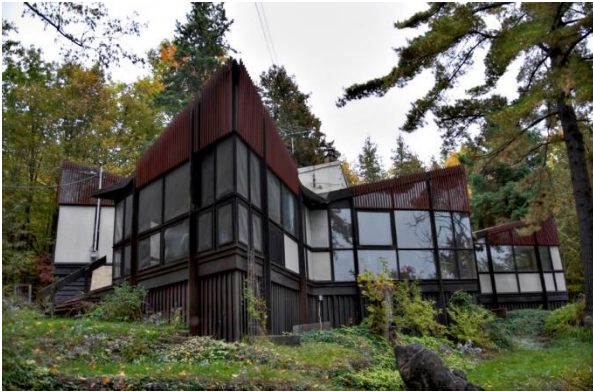
Figura 5. Casa Strutt, 2010 integración con el entorno del Parque de Gatineau.
