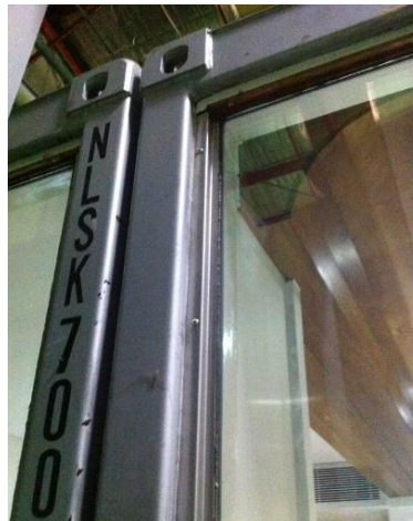
Figura 53: Junta d'unió ISO en construcció d'habitatges
