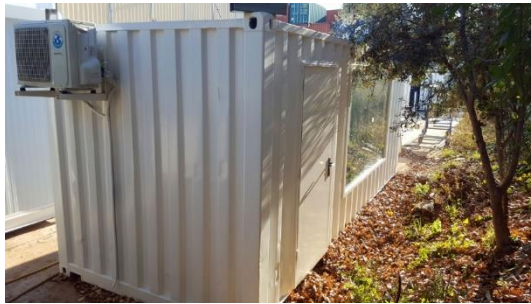
Figura 36: Exemple instal·lació exterior bomba de calor en contenidor marítim
