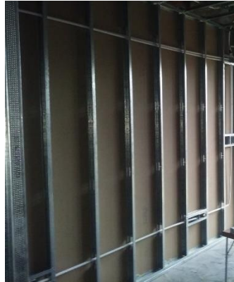
Figura 30: Instal·lació tipus Drywall
