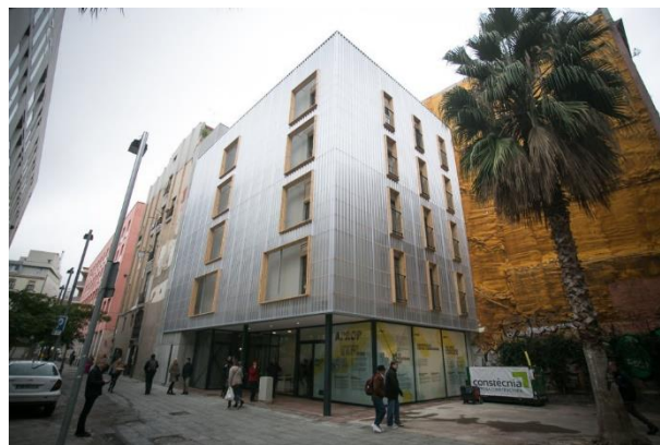
Figura 1: Edifici habitatge públic (Barcelona, España)
