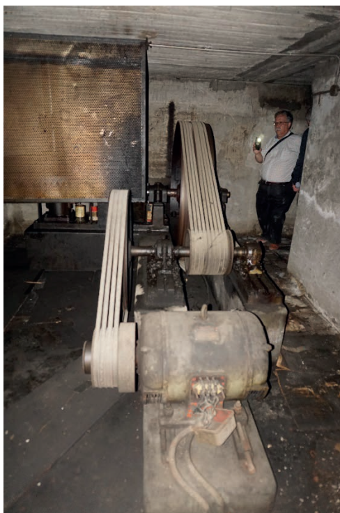
Figura 5: Instal·lació subterrània que mou una mola al pis superior (Foto: MMG).
