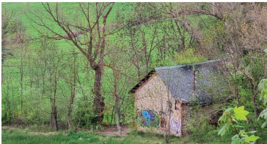
Fig. 1. Central elèctrica construïda el 1912.
