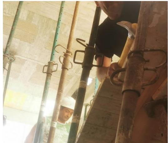
En las dos siguientes imágenes se muestran al encargado y a un operario realizando los cortes de armadura in situ en el lugar de trabajo. Ninguno de los dos lleva colocada la mascarilla como se debería llevar, ni otros EPI's necesarios para la actividad que desarrollan, además solo uno de todos los trabajadores, el encargado, el único operario en toda la obra en usar el casco, se encuentra fumando dentro de horario y lugar de trabajo.
