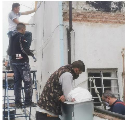
En las dos siguientes imágenes se puede al último trabajador que no se apreciaba en la primera imagen. Estos dos trabajadores con mascarilla estaban realizando un cambio de tubería por las pérdidas que tenía la anterior.
