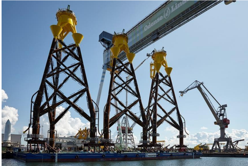
Figura 8: Imagen de una estructura Jacket Hotchief [19]
