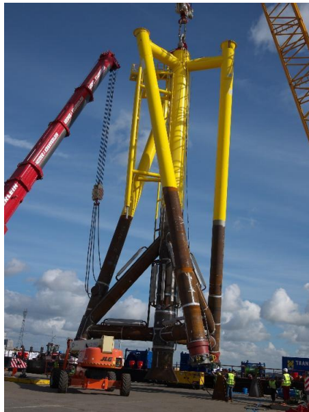
Figura 9: Imagen de estructura jacket de tipo Twisted [20]
