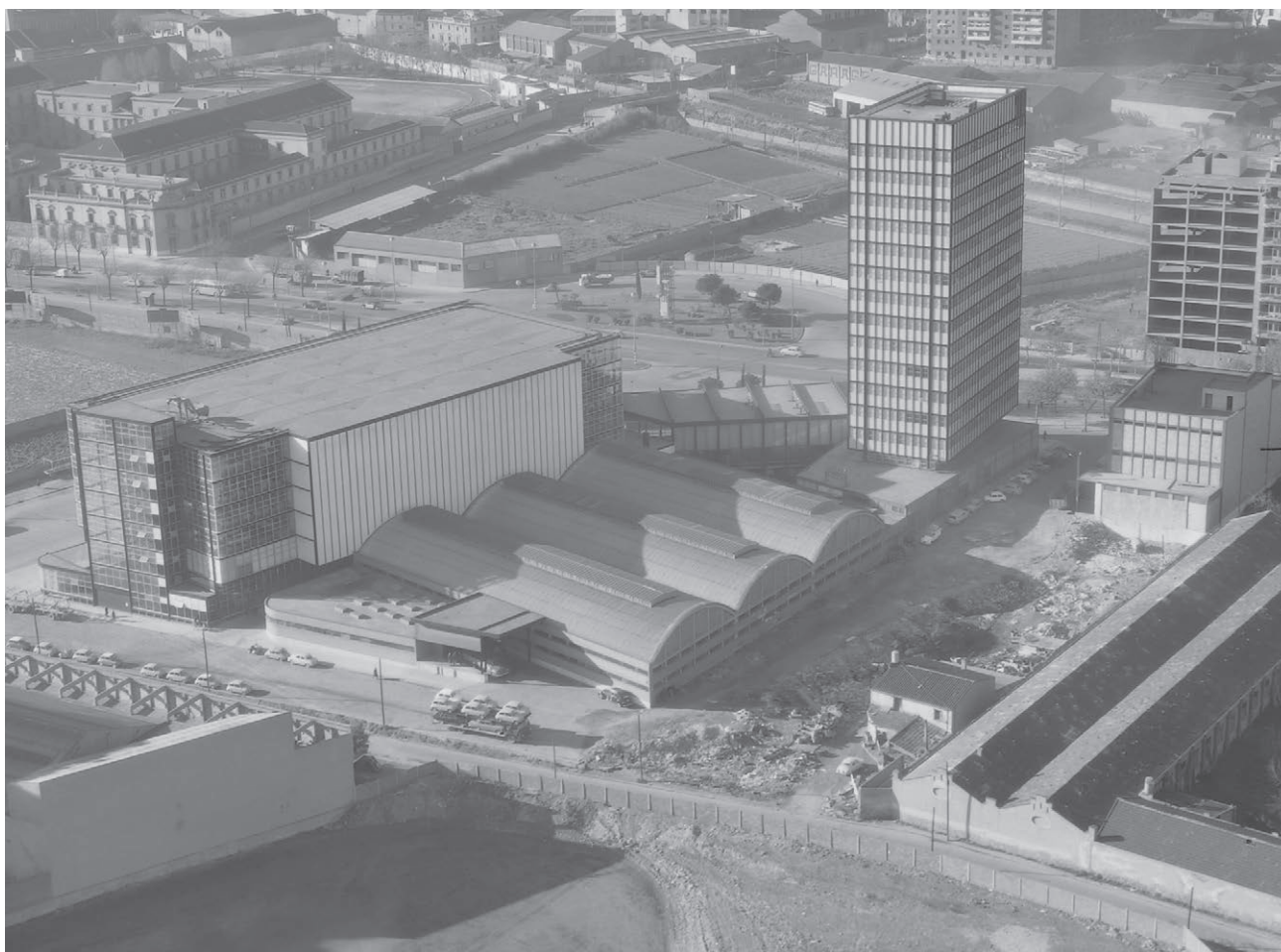
Vista aérea del conjunto de edificios de la Filial de SEAT en Barcelona. En primer término se puede apreciar el edificio A, correspondiente a los talleres. Fondo fotográfico de TAF Helicópters S.A / Arxiu Nacional de Catalunya / Referencia 506822.
