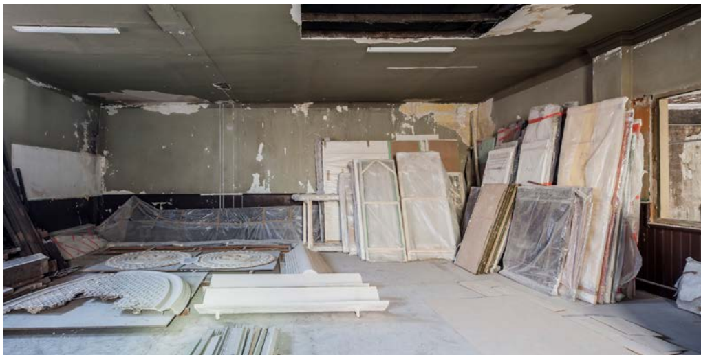
1. La sala Beckett del Poblenou en obres. © Adrià Goula.
