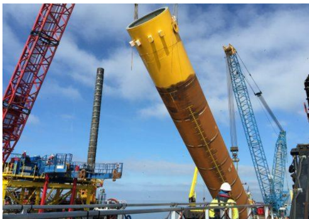
Figura 46. Pilotes hincados 01. Fuente: google.com
