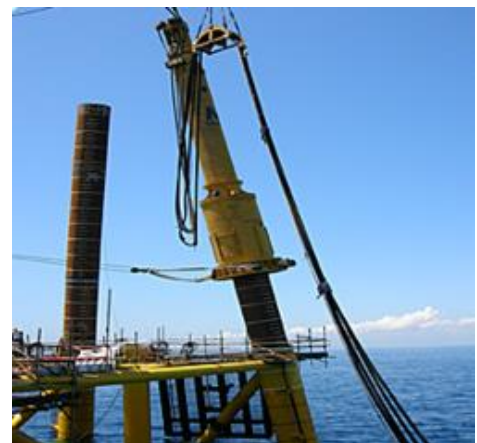
Figura 47. Pilotes hincados 02. Fuente: google.com
