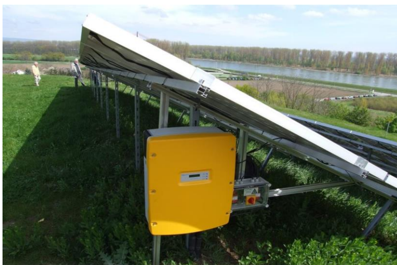
Figura 12: Inversor DC/AC de String. Fuente: factorenergia.com
