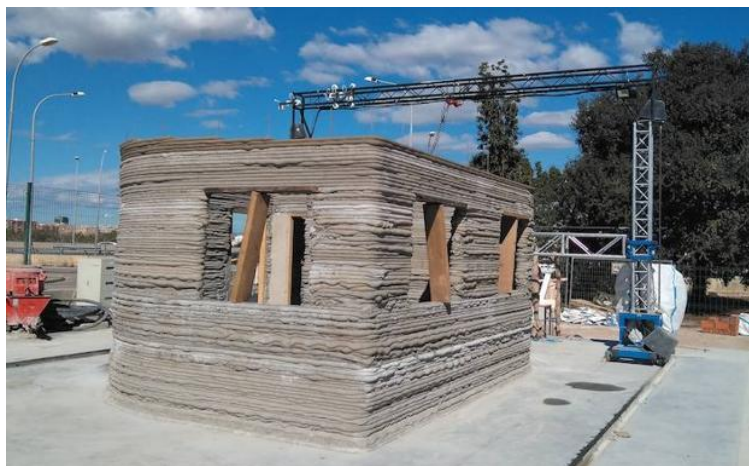
Figura 28. Casa impresa con hormigón.
