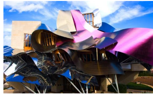
Fig. 94: Bodega Marqués de Riscal
