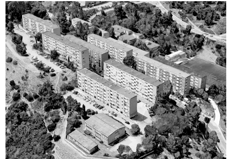
Edificios de viviendas del barrio de Ciudad Meridiana. Fachada Sur. Barcelona. Google Maps.
