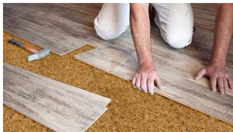
Ilustración 52: Colocación de suelo de corcho y parquet (Fuente: https://www.hechoencorcho.com/rollos-de-corcho-para-pared-y-suelo/ )
