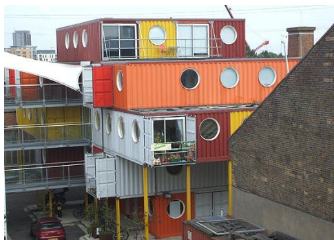
Ilustración 2: Ciudad contenedor ubicada en Londres (Fuente: https://es.wikiarquitectura.com/edificio/container-city/ )
