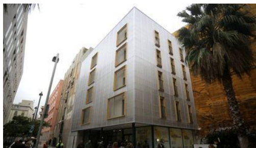
Ilustración 3: Edificio a partir de contenedores marítimos en Barcelona (Fuente: https://www.elperiodico.com/es/barcelona/20191216/barcelona-termina-edificio-pisos-contenedor-7776831 )
