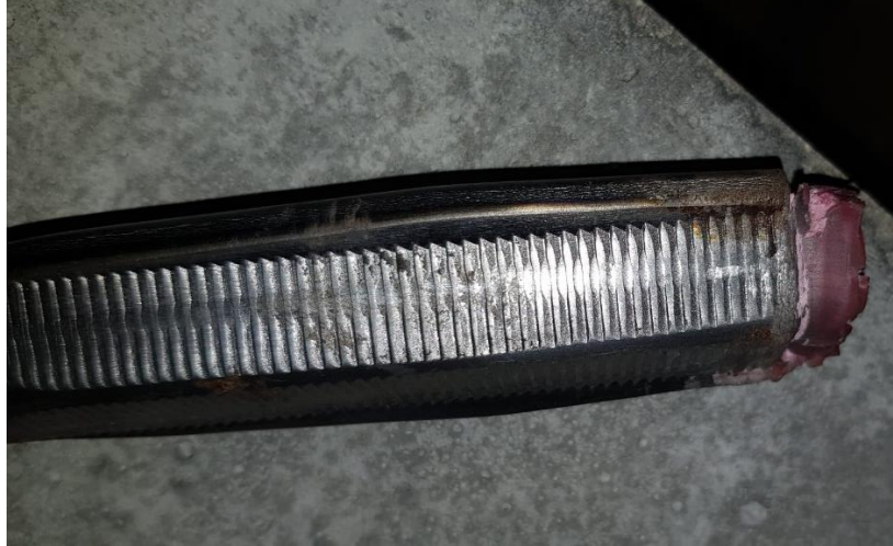
Figura 4.3 Desprendimiento de la resina en las abrazaderas de las barras
