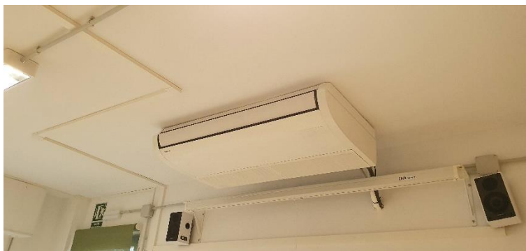
Figura 46. Equip d'aire condicionat gran (biblioteca i sala de professors) (font pròpia).
