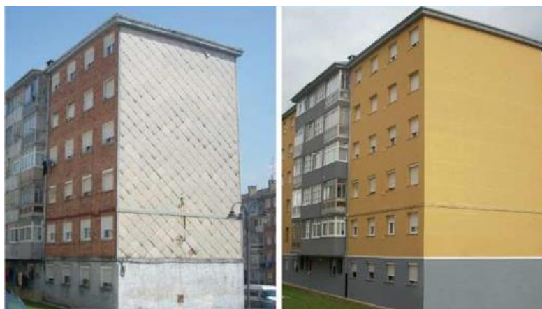
Figura 70. Edifici abans i després de l'aplicació del SATE [34] .
