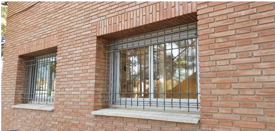
Figura 60. Finestres façana SO (font pròpia).
