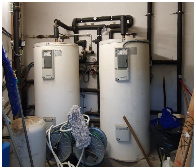
Figura 44. Acumuladors gimnàs (font pròpia).
