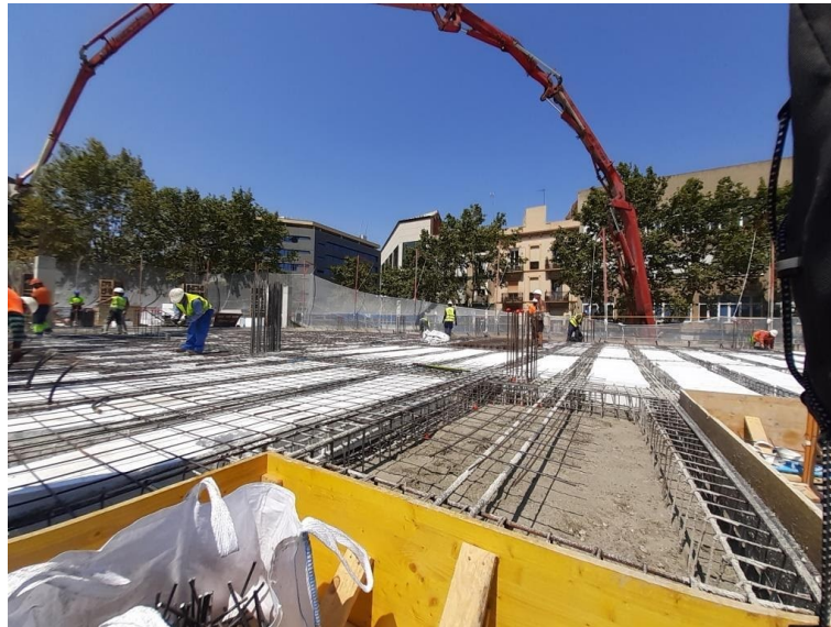
Figure 12 Material storage on the construction site (Universitat Politècnica de Catalunya, 2021)
