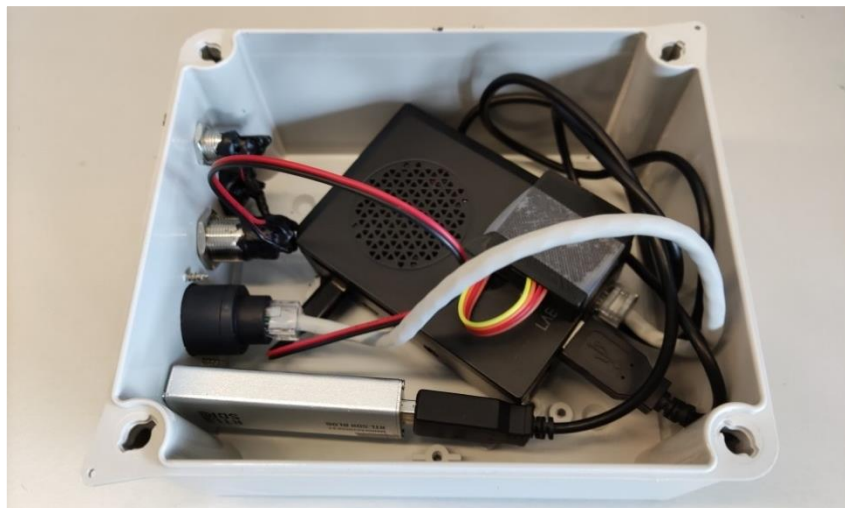
Fig. 4.14: Conexionado final dentro de la caja.
