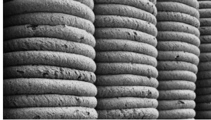
Figura 30. Hormigón visto construcción aditiva.
