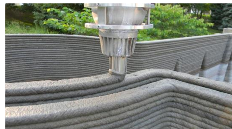
Figura 7. Extrusión de material, 3DCP.
