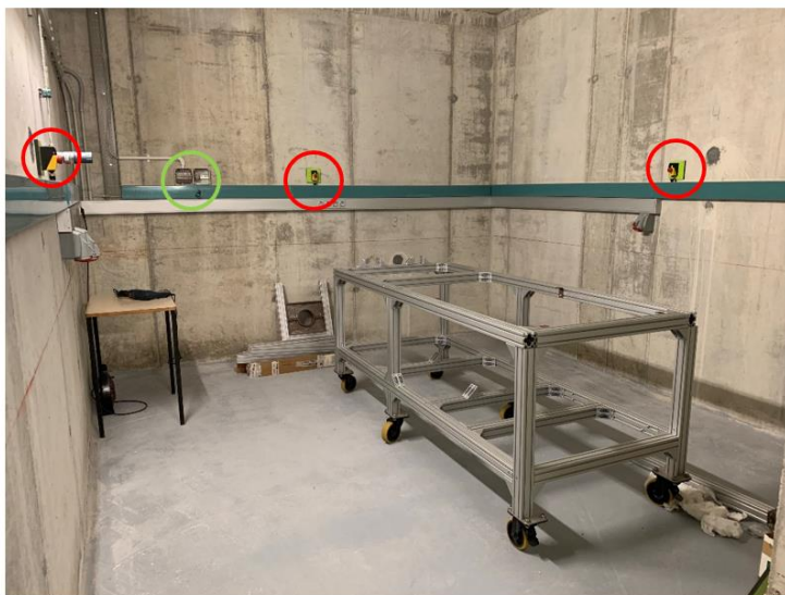
Figura 8: Polsadors d'emergència (encerclats en vermell) i polsador de la seqüència de sortida (encerclat en verd).
