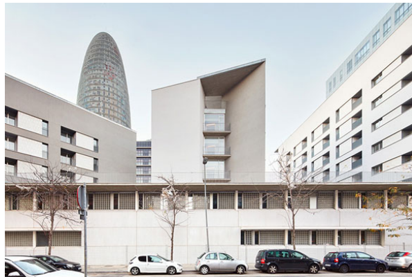
Figura 7. Exterior del edificio. Revista ON Diseño. Fotografía: José Hevia Recuperado de: http://www.ondiseno.com/proyecto.php?id=2587
