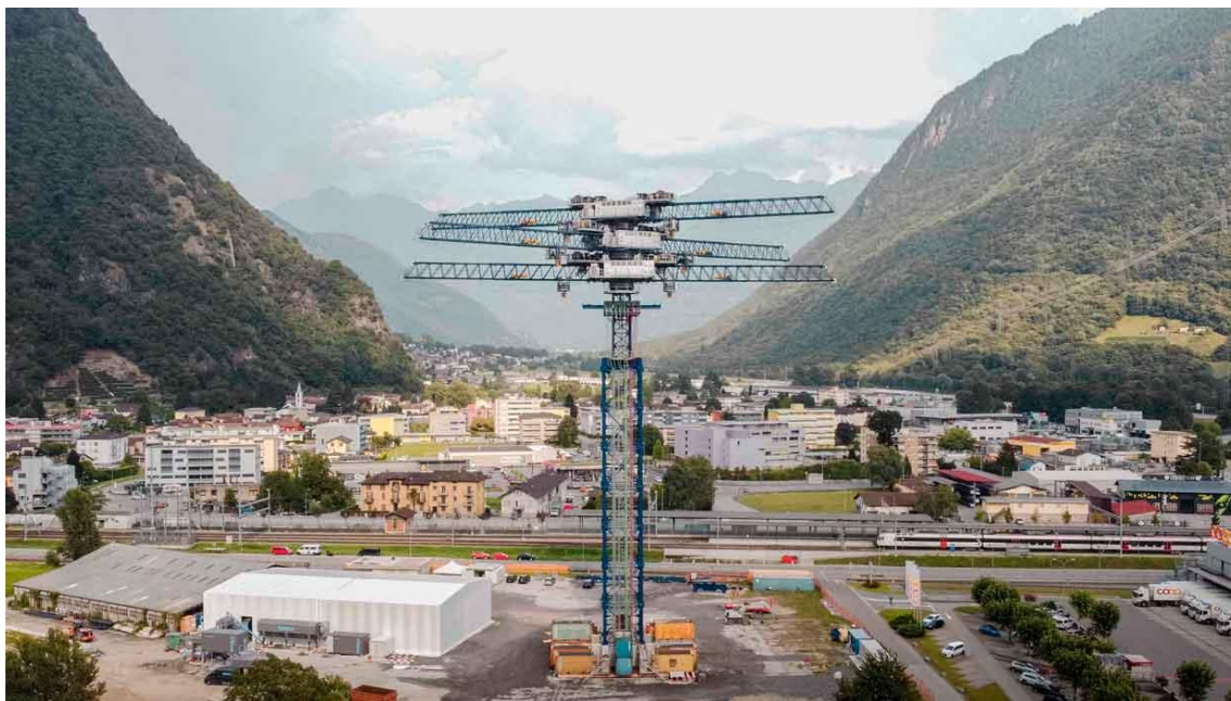
Figura 8.2. Aparència de la instal·lació en una zona habitada, Ginebra, Suïssa. Font: energyvault.com.
