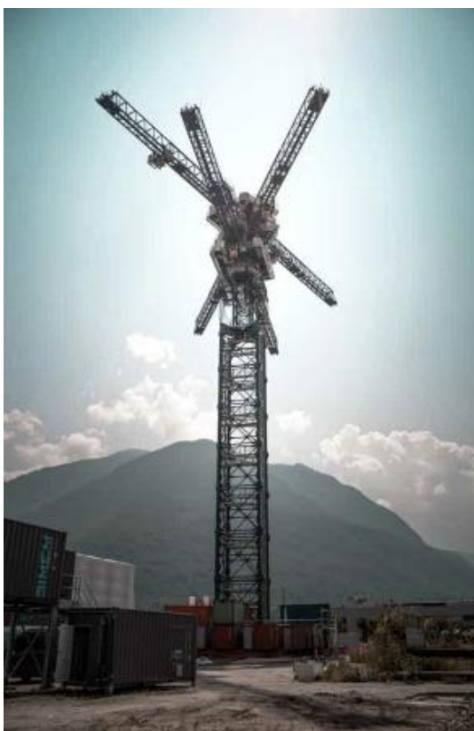
Figura 2.1: Prototip de central d'emmagatzematge d'energia potencial, Ginebra, Suïssa. Font: web Energy Vault.
