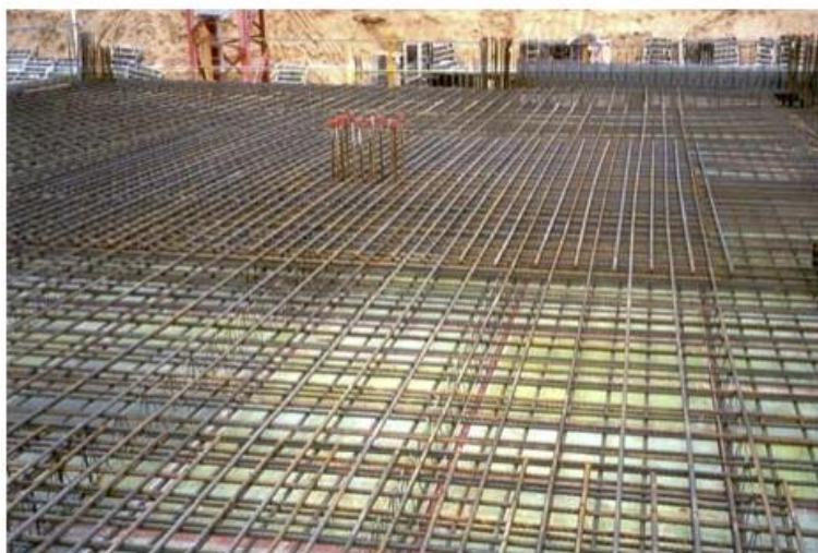
Figura 5.10. Aspecte típic d'un encofrat abans de col·locar-hi el formigó per a consolidar un forjat. Font: http://oa.upm.es/55966/1/Proyecto_estructuras_hormigon.pdf
