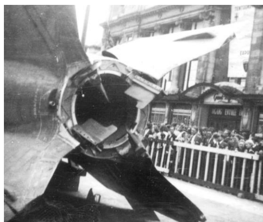
Figura 2.2. “Exhaust vanes” en un V-2 de 1945 (Fuente: Wikipedia [3]).
