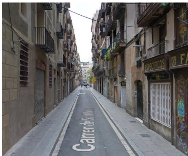
Il·lustració 1. El carrer Sant Ramon a l'alçada de l'edifici a estudi.
