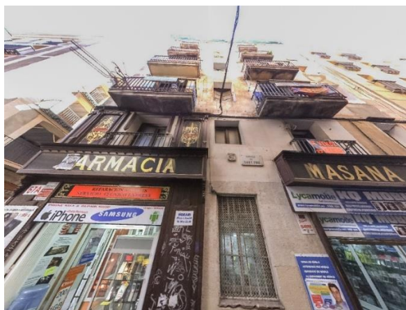
Il·lustració 5. Imatge de la façana principal de l'edifici. Font: Cadastre [6].
