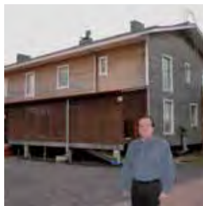
Una casa de baixa energia, feta amb materials naturals, permet reduir el consum elèctric a la meitat.
