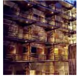
Accessos a través de passarel·les a l'edifici d'habitatges per a joves (Mataró).
