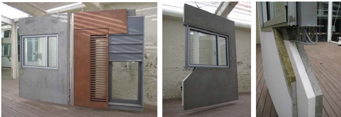
Figura 13. Componentes completos de fachada con paneles de HUAR de 4cm de espesor.
