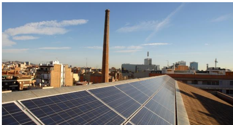
Figura 11.28 Disposició de les plaques solars a les teulades dels edificis.[45]
