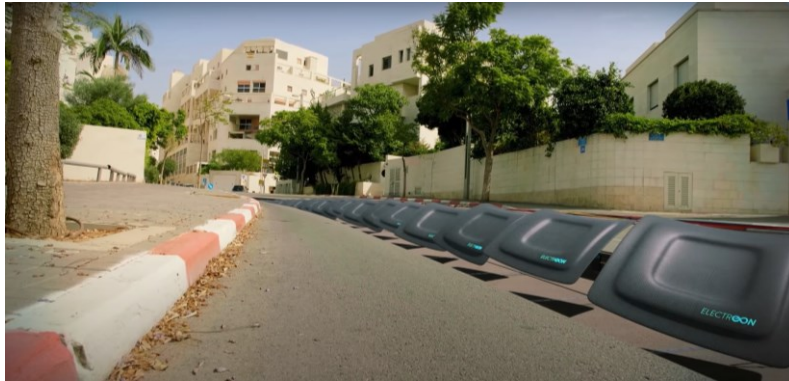
IL·LUSTRACIÓ 59. BOBINES EMISSORES 76
