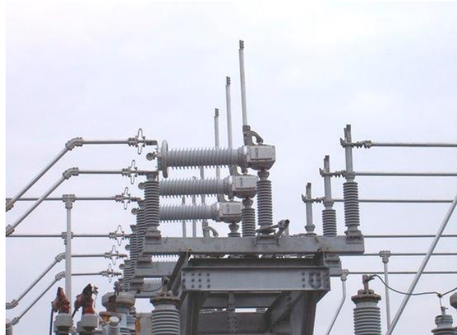
Ilustración 5: Interruptor seccionador de alta tensión [11]
