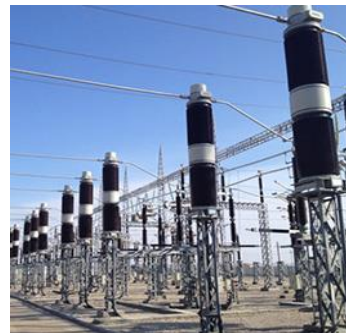
Ilustración 7: Transformador de corriente [13]
