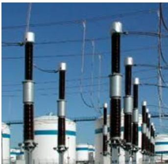
Ilustración 6: Transformador de tensión [12]
