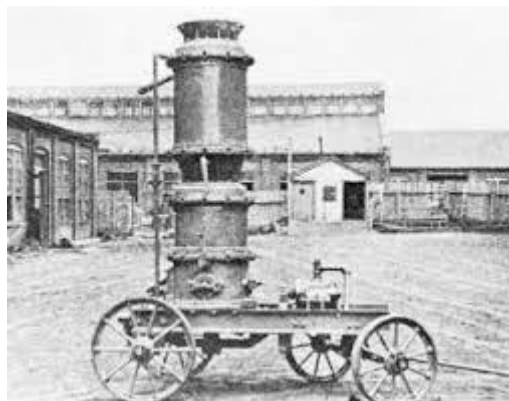
Figura 1. Máquina original utilizada en 1907 para recubrir la fachada del Field Museum of Chicago [12].
