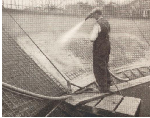
Figura 2. 'Nozzleman' aplicando hormigón proyectado para una instalación de almacenamiento de agua en Pittsburgh, 1919 [13].
