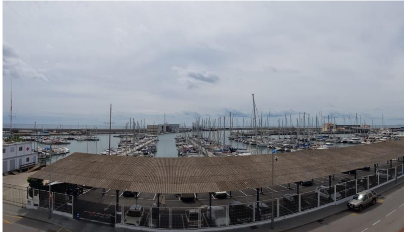
Figura A.13: Panoràmica Club Nàutic Arenys de Mar
