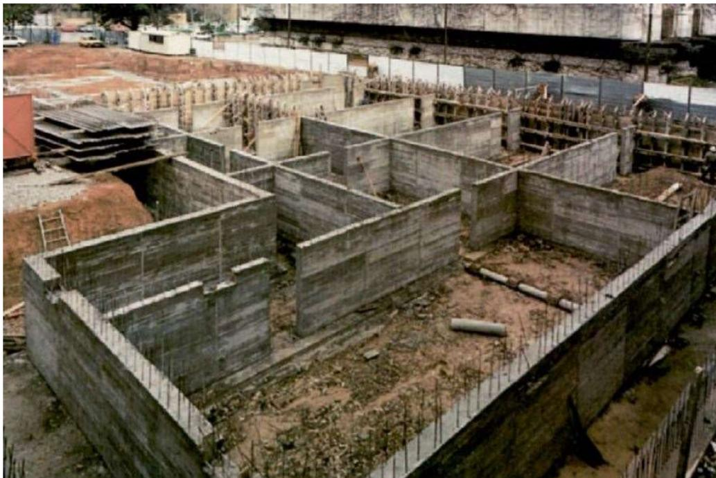
*Fig. 4 Construcción del sótano en el Pabellón Alemán, espacio que permitirá mantener el edificio perfectamente conservado.*
