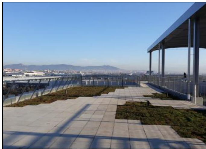
Fotografía A.9: Cubierta transitable del Bio-Edificio Gonsi Sócrates (Construcúa and Eco Intelligent Growth, 2020)
