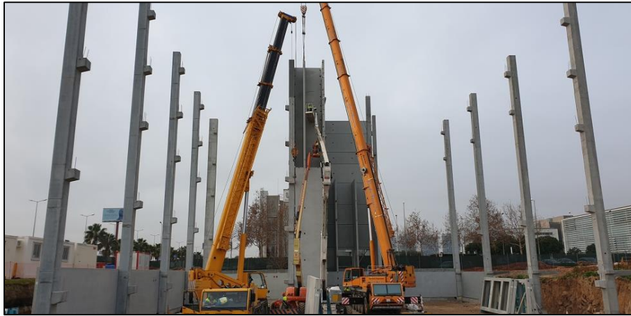
Fotografía A.1: Montaje de pilares del Bio-Edificio Gonsi Sócrates (Pich-Aguilera and Batlle, 2020)
