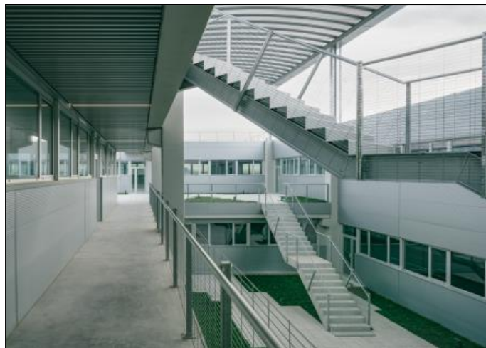
Fotografía A.6 Escalera exterior metálica del Bio-Edificio Gonsi Sócrates (Construcúa and Eco Intelligent Growth, 2020)
