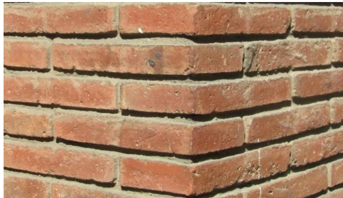
Figura 2.2.1 Obra de fábrica de ladrillo
