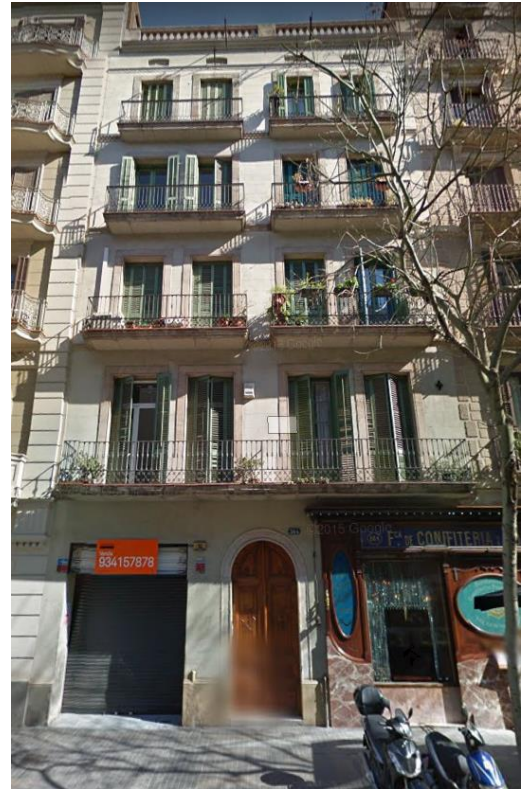
Figura 3.1.14 Fachada principal del edificio de la calle de Consell de Cent 364
