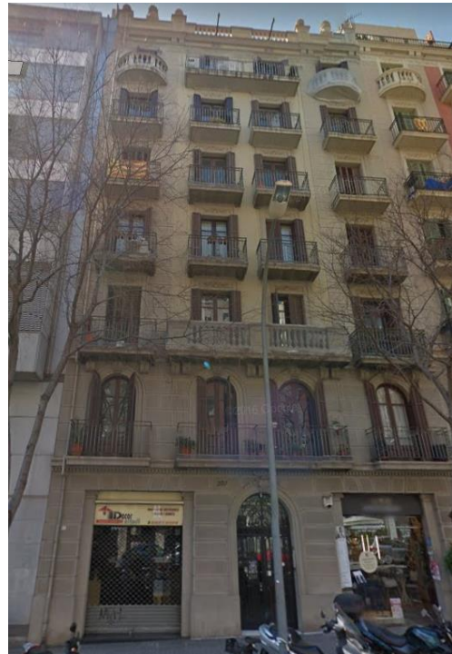
Figura 3.1.8 Fachada principal del edificio de la calle de Calàbria 207
