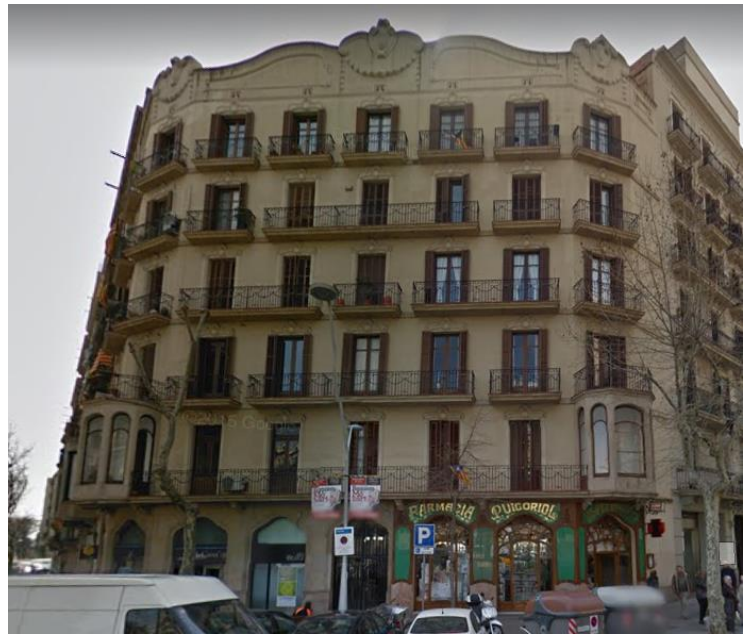
Figura 3.1.20 Fachada principal del edificio de la calle de Mallorca 312
