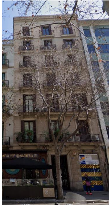
Figura 3.1.11 Fachada principal del edificio de la calle de Consell de Cent 362
