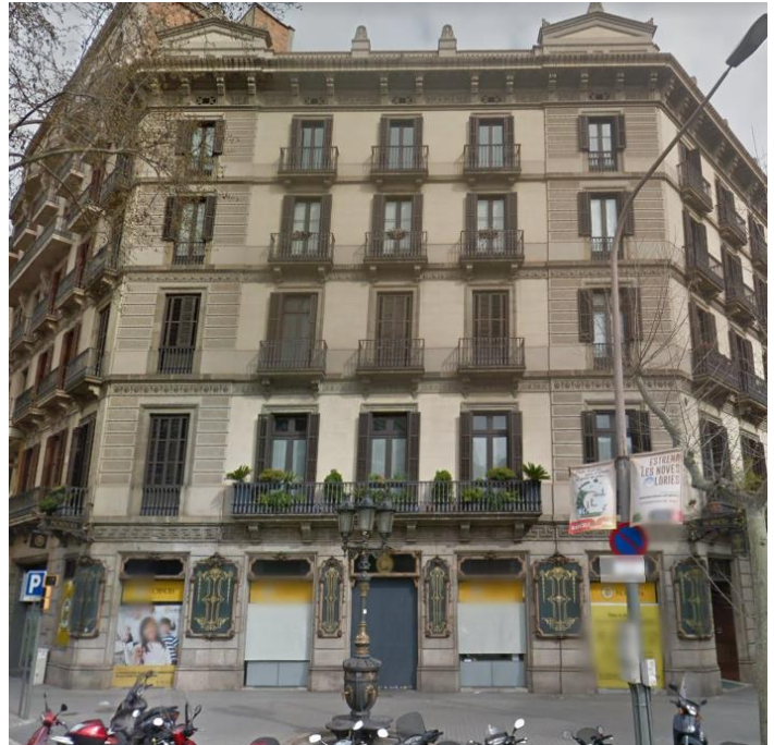
Figura 3.1.23 Fachada principal del edificio de la calle de Pau Claris 96
