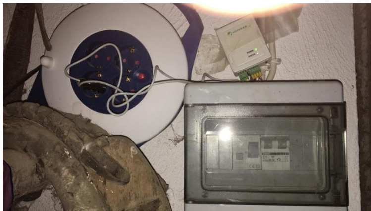
Figura 5.3. Instal·lació de l'equip de monitorització Mirubee[Font pròpia]
