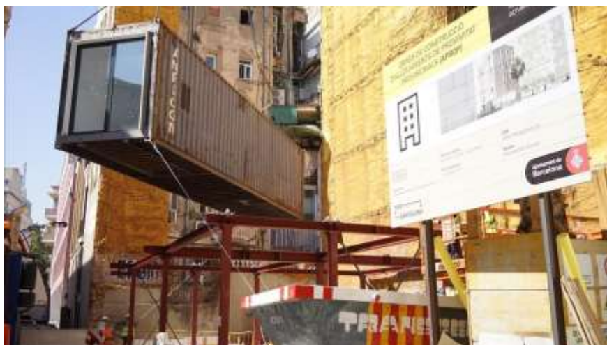
Imatge 4: Construcció de l'edifici de protecció oficial a Ciutat Vella
