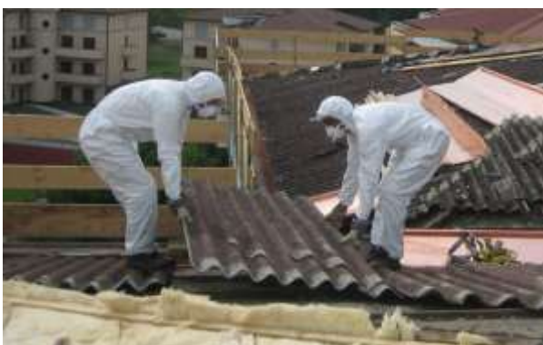
Imatge 2: Eliminació de teulades amb fibres d'amiant
