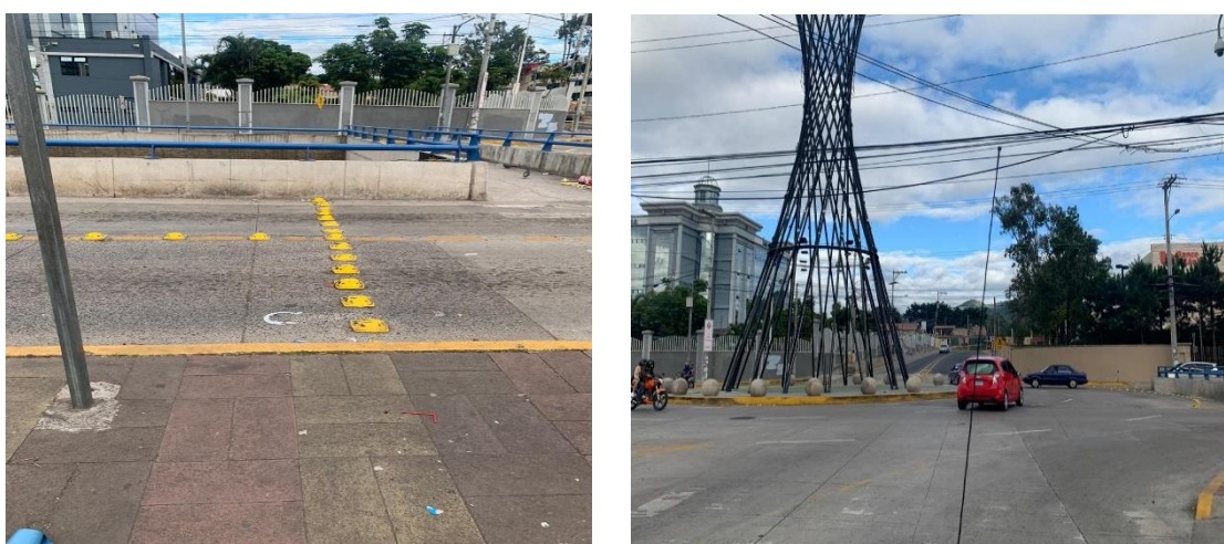
Figura 20: Boyas utilizadas para reducción de velocidad y separación de carriles
