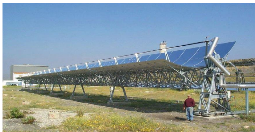
Figura 8.15 Col·lector EuroTrough ET150 en operació a Almeria [23].
