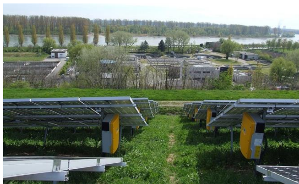
Figura 7.16. Posicionament dels inversors sota les plaques [30].
