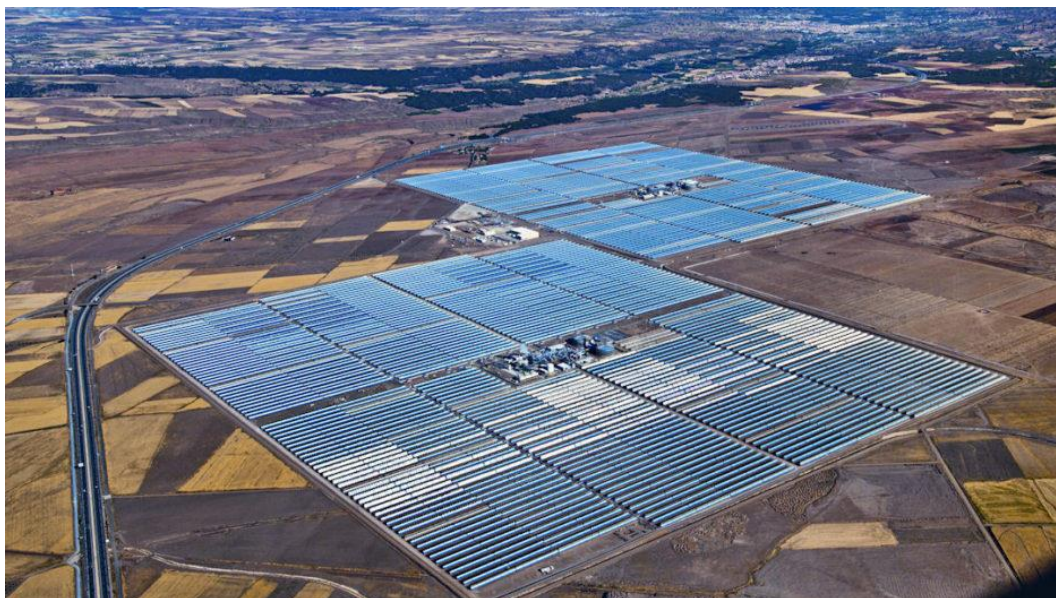
Figura 5.15 Central termosolar Andasol de concentradors cilíndrics parabòlics d'Aldeire. [17]
