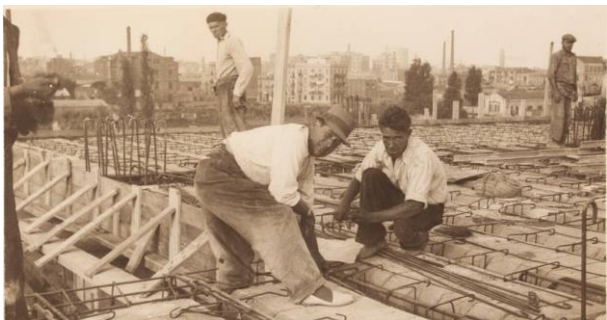
Figura 10. Construcció d'un forjat de la Hispano-Olivetti de Barcelona el 24 de setembre de 1941. Fons Hispano-Olivetti.
