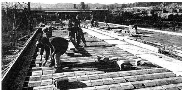
Figura 19. Fotografia de l'execució d'un dels forjats. DOCOMO.
