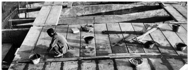
Figura 23. Execució de la 2ª fase. Fons SELEZ.
