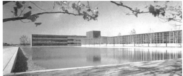
Figura 8. Centre tècnic de General Motors a Warren, Michigan. Construït per Eiel i Eero Saarinen entre el 1948 i el 1956.
