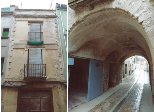
Figura 4. Imagen de la arquitectura de la zona. A la izquierda una fachada revestida con yeso y a la derecha una bóveda de yeso.
