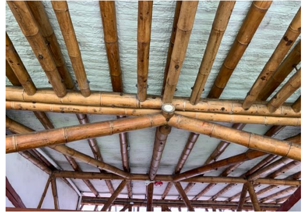
Figura 4. Imagen de unión mediante pernos. Foto: autor.
