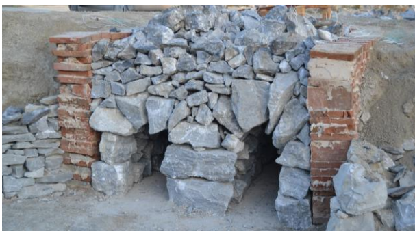
Figura 5. Imagen del horno del yeso tradicional construido.
