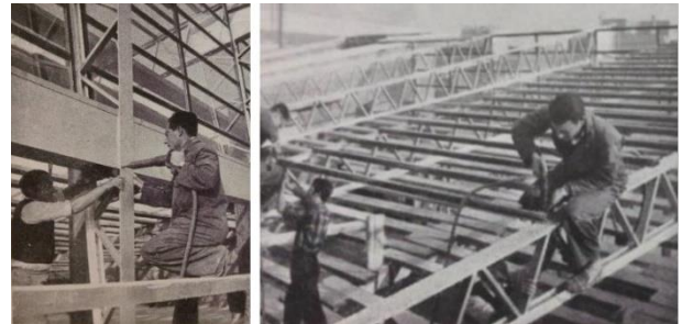
Figura 16. Imatges de l'execució de les obres de muntatge de l'estructura d'alumini. IC n° 79
