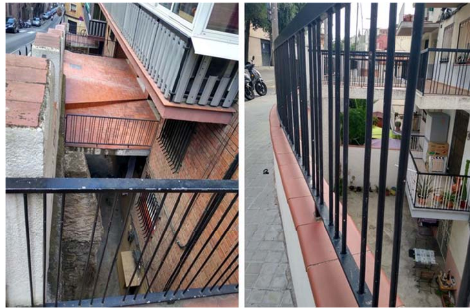
Ventilació de plantes soterrani a través de patis frontals a façana de varies plantes de profunditat
