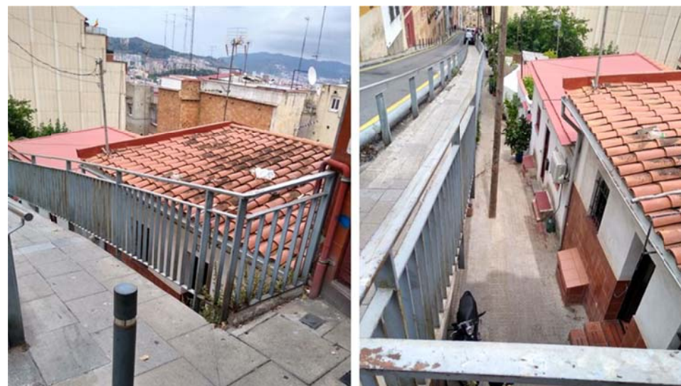
Ventilació de plantes soterrani a través de patis frontals a façana de varies plantes de profunditat
