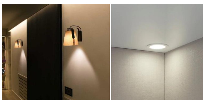
Figura 5.57 Luces del pasillo (izquierda) (Fuente: [33]. www.lamparas.es ) y del baño (derecha) (Fuente: [32]. www.leroymerlin.es )
